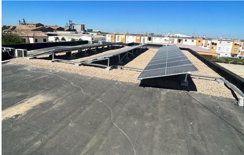
CEIP Florentina Bou (Paneles FV y mejora de la cubierta)
