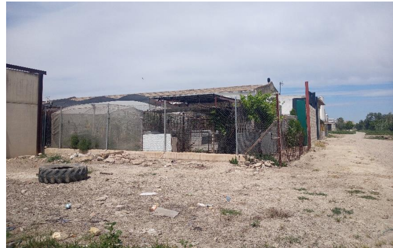
Foto: Las naves e infraviviendas en príncipe de Gales con malas condiciones de accesibilidad.
