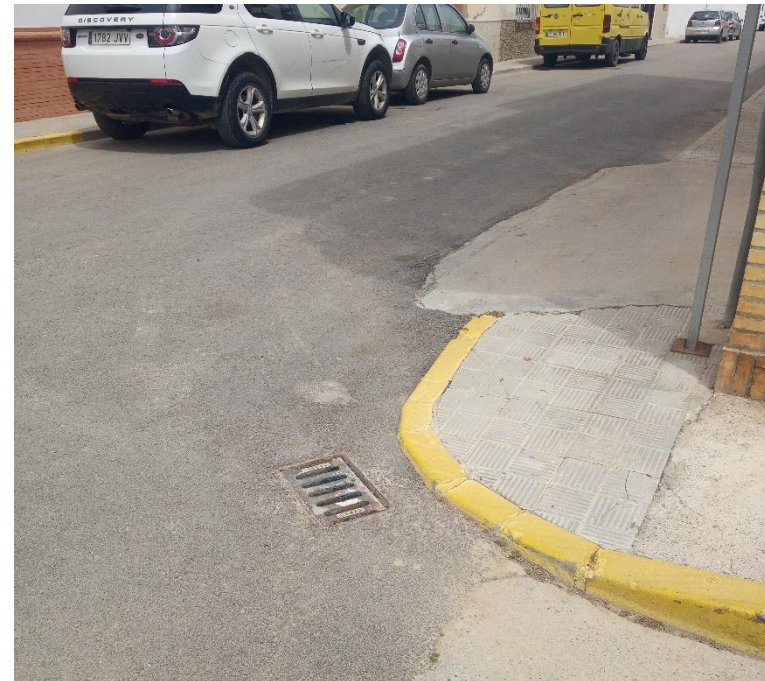
Foto: Pendientes laterales en numerosas aceras dificultan el tránsito peatonal, con carritos, bastones, sillas de ruedas.
