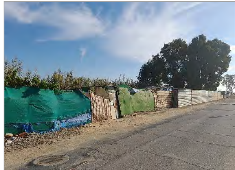
Ocupación del espacio público sobrante en los canales por construcciones marginales en el Pob. de Alfonso XIII.
