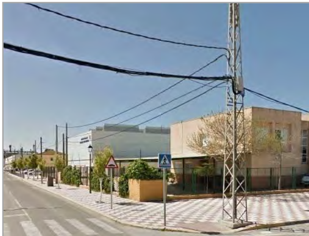
Postes eléctricos situados en la travesía (Av. Blas Infante).
